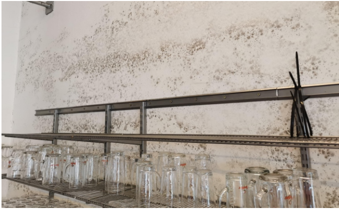
Bereits kurz nach den schweren Regenfällen im September trat im Feuerwehrhaus massiver Schimmelbefall auf
