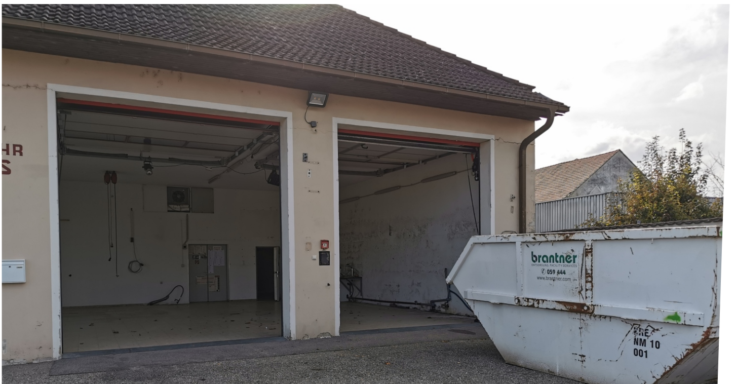
Das Feuerwehrhaus musste komplett geräumt werden.
