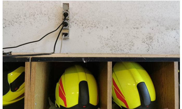
Bereits kurz nach den schweren Regenfällen im September trat im Feuerwehrhaus massiver Schimmelbefall auf
